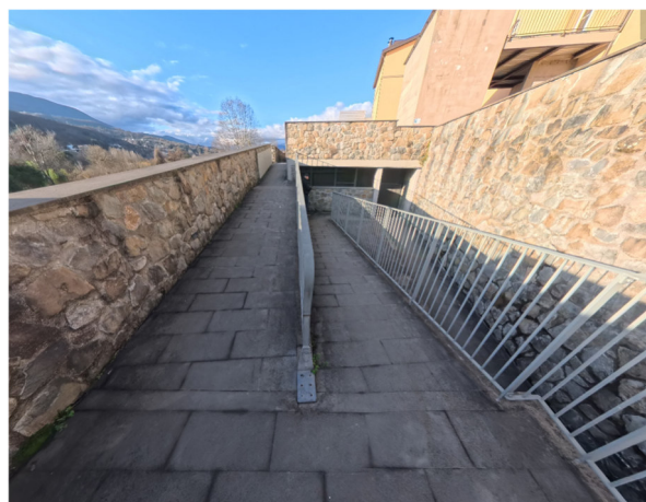
29 Rampa che collega ascensore – Teatro
