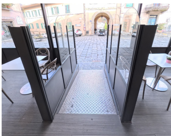
38 Rampa per accesso Bar
